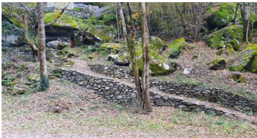
Accesso Mondada a lavori conclusi
